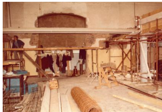
Les travaux de la Frat', pour devenir telle qu'elle est aujourd'hui !
