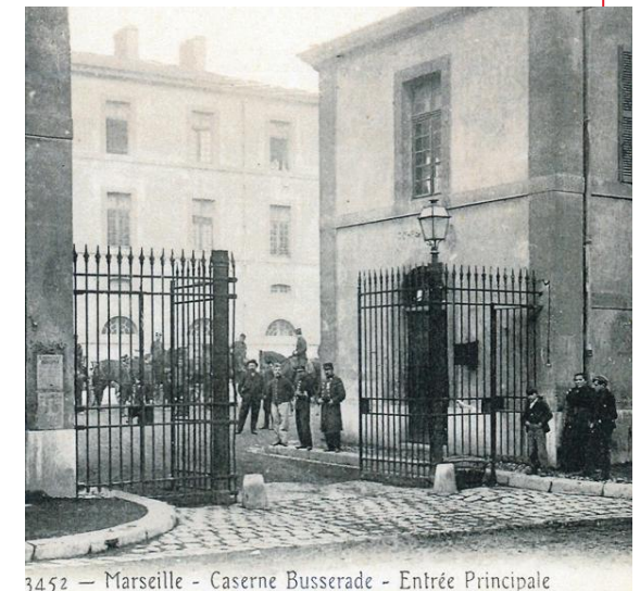
3452 — Marseille - Caserne Busserade - Entrée Principale
